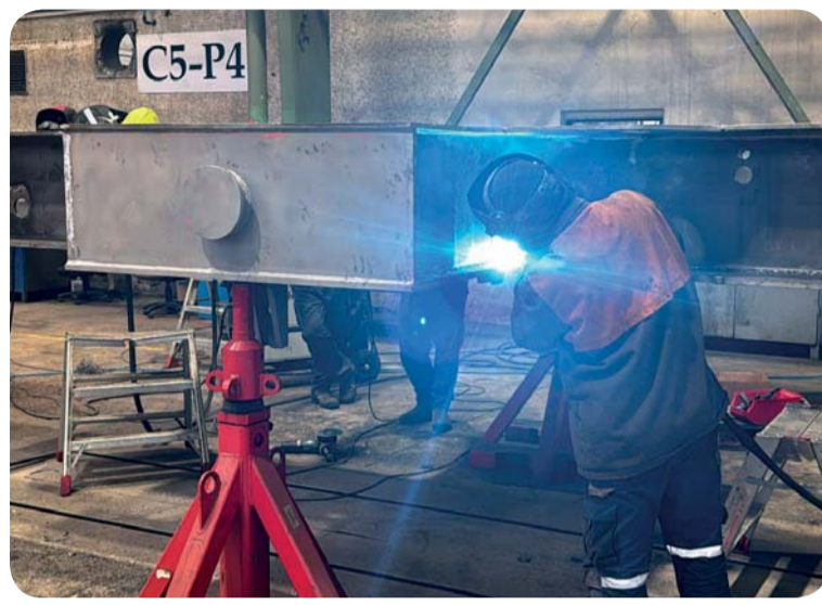
Modernizace hlavního rámu.
