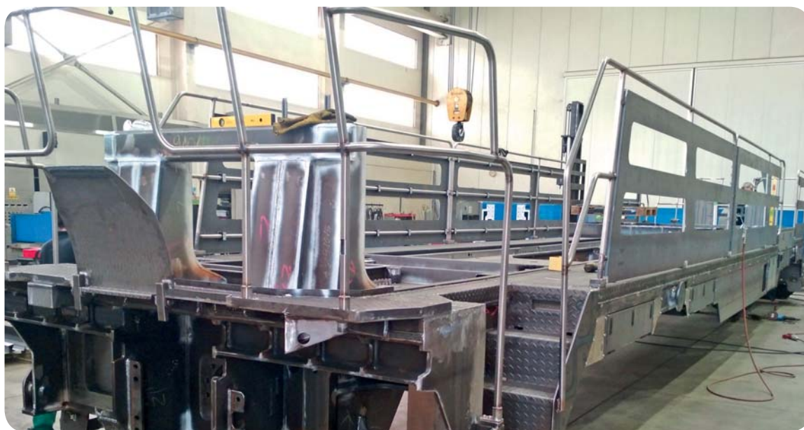
Zkušební montáž zábradlí na hlavní rám EffiShunteru 1000 - 744.127 SŽ-PP Slovinsko.
