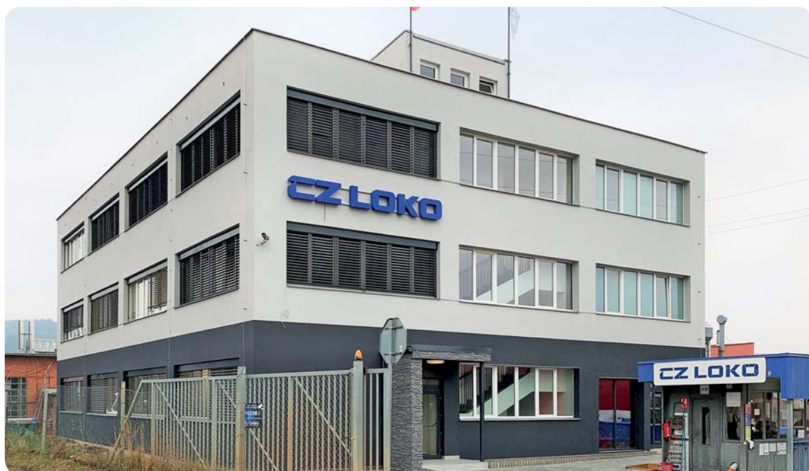
Administrativní budova v České Třebové vznikla rekonstrukcí někdejší „Třačky“ v sousedství Semanínské ulice. Stejně jako v jihlavské provozovně bylo cílem veškerou administrativu co nejvíce koncentrovat mimo výrobní prostory.
