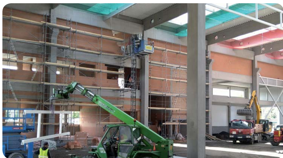
Stavební práce v Jihlavě pokračují podle plánu. Montážní hala má již kompletní opláštění, nejvíc práce tak zbývá udělat na vnitřním vybavení.
