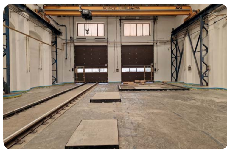
Rekonstrukce haly tzv. rámrny jde do finále. Na snímku betonáž podlahy.
